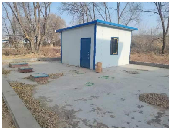
生活污水处理站
