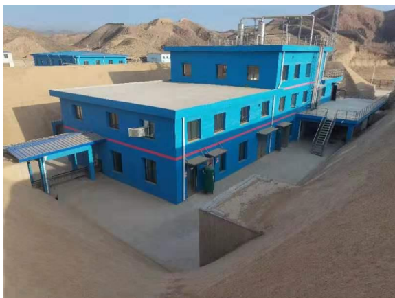
膨化硝铵炸药生产工房
