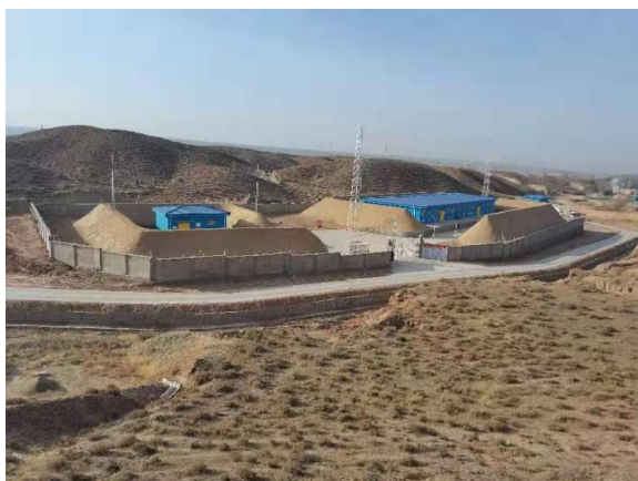
总库雷管库和黑索金库
